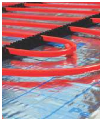
Montare țevă cu șină de fixare
