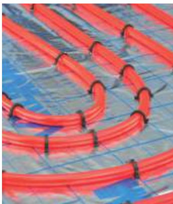
Montare țevă cu clips și tacker
