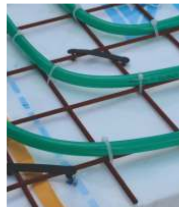
Montare țevă cu coliere pe plasă metalică
